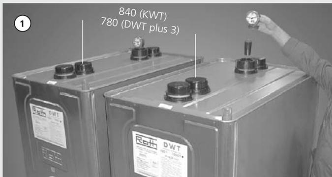
DWT plus 3 auf Fußgestell, KWT auf Boden aufsetzen und im Tank-Mittenabstand von 780 mm (DWT plus 3) bzw. 840 mm (KWT, Abstandsteller verwenden) nebeneinander aufstellen; Füllstanduhren in Gewindebuchsen auf dem 3. Tankstutzen einschrauben (DWT plus 3).
