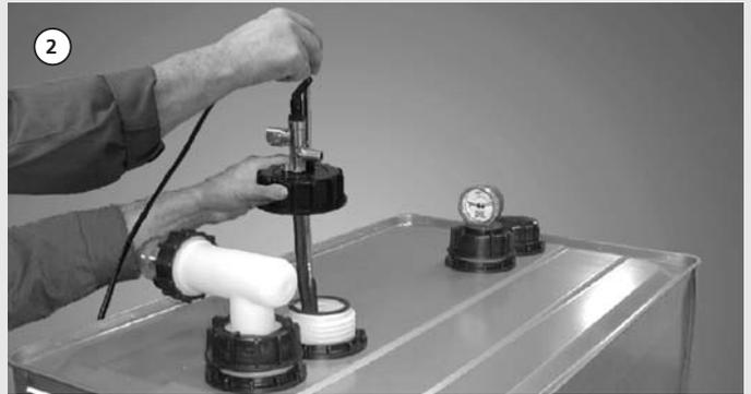
Entnahme-Sammelarmatur mit Grenzwertgeber auf 2. Tankstutzen aufsetzen.
