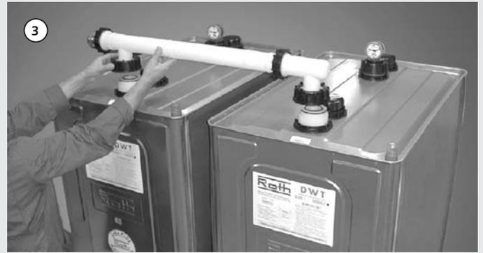
Auf 1. Stutzen mit eingesetztem Tauchrohr aufsetzen.
