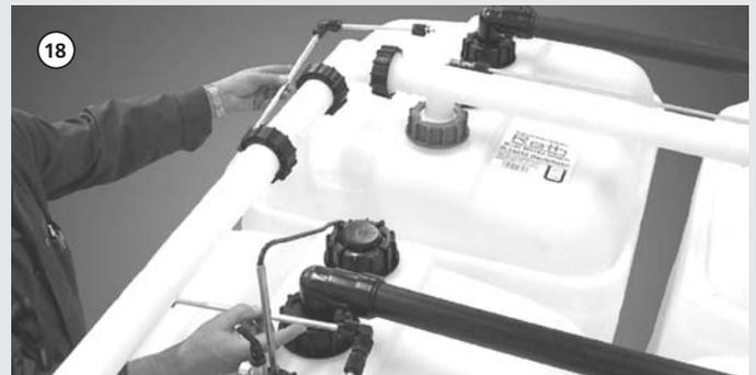
An die einzelnen Entnahmeleitungen anschrauben.
