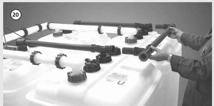
In die einzelnen Entlüftungsleitungen einstecken. Fertig montierte Leitungssysteme.
