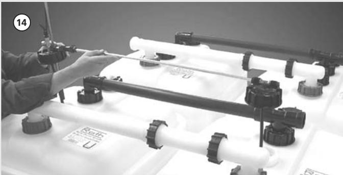
Entnahmeleitung auf den 2. Tankstutzen aufsetzen; dabei Sammelarmatur mit GWG auf 1. Tank in Füllrichtung montieren.
