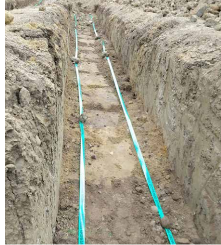
Warnbänder über dem verlegten GeoCollect-System
