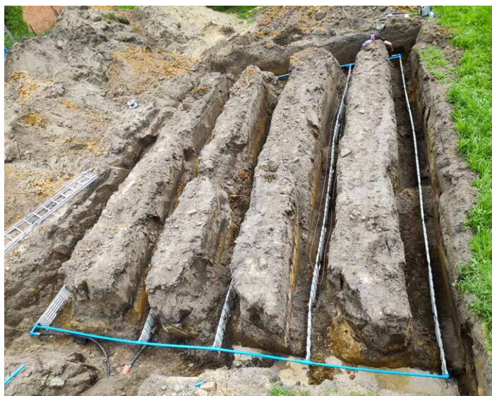
Beispiel einer Tichelmann-Verlegung von 5 GeoCollect-Strängen
