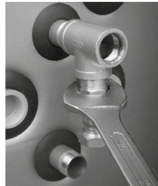
4. Den 90° Bogen auf Muffe 2 schrauben und in Position bringen (Bogen muss nach oben zeigen).
