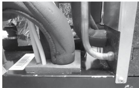
Verschließen der Einführung in das Gerät mit Hilfe des beigelegten Schaumstoffes. Kabel durch die passenden Löcher einführen.
