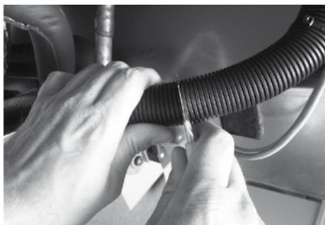
Vorsichtiges Aufschneiden des Kabelschutzrohres oberhalb des Verdampfers (Achtung innenliegende Kabel nicht beschädigen)
