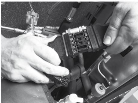
Wurden alle sechs Stecker angeklemmt, müssen sie im Außengerät miteinander verbunden werden.
