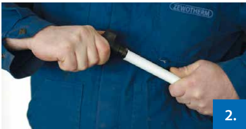
Abbildung 2: Kalibrierung und Entgraten des Rohres
