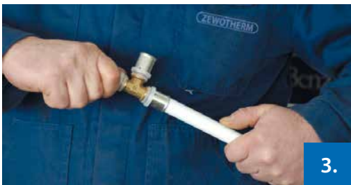
Abbildung 3: Einsetzen des Fittings
