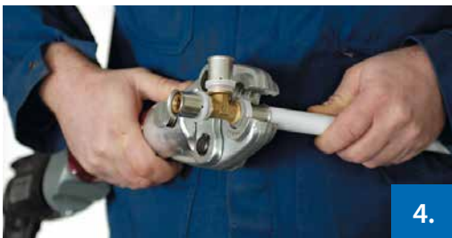
Abbildung 4: Verpressung / Beenden des Pressvorgangs
