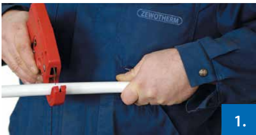
Abbildung 1: Ablängen des Rohres
