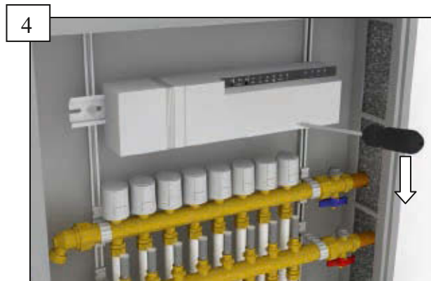
4 Abdeckung mit einem Schraubendreher abnehmen
