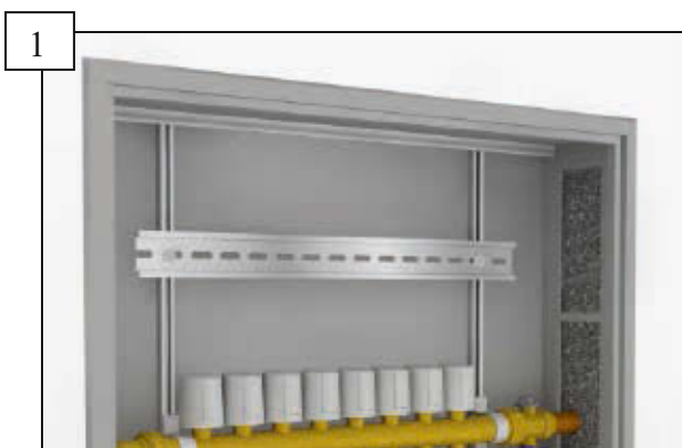
1 Eine Hutschiene aufputz oder im Heizkreisverteilerschrank montieren.
