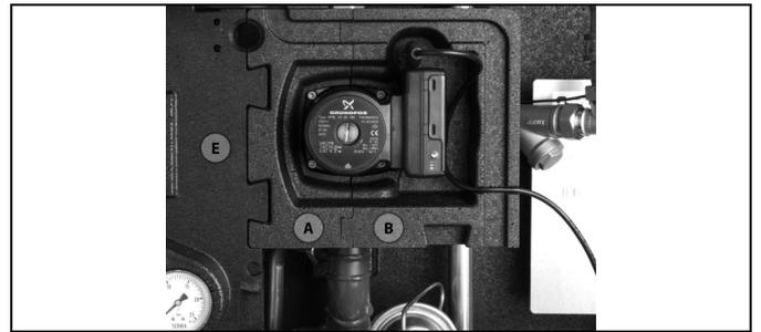
Montieren Sie Block F (beim VM2-Ventil Block G). Der Block ist drehbar und kann um das Ventil herum gezogen werden. Befestigen Sie den Block an den Blöcken B/D und E.
