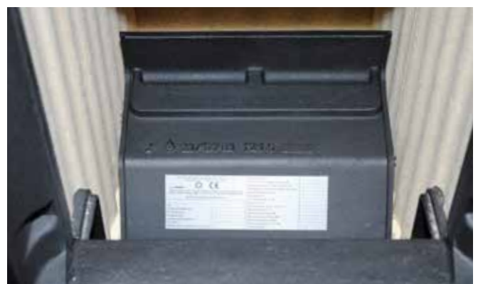
Abb. 2: Typenschild auf Luftkanal vorn im Feuerraum
