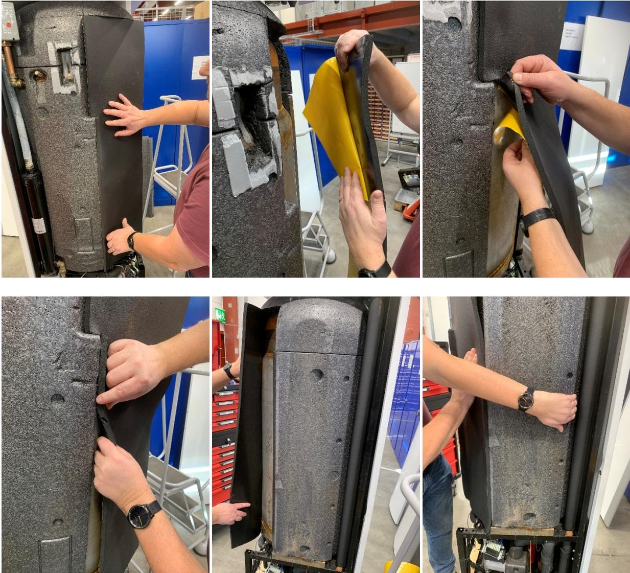
21. Zur zusätzlichen Dämmung die Verbindungsstelle zwischen der aufliegenden Dämmung und der neuen Dämmung mit zwei der drei beiliegenden Stücke Armaflex-Tape überkleben. (Das dritte Stück ist zur Dämmung des Vorlauftemperaturfühlers vorgesehen.)
