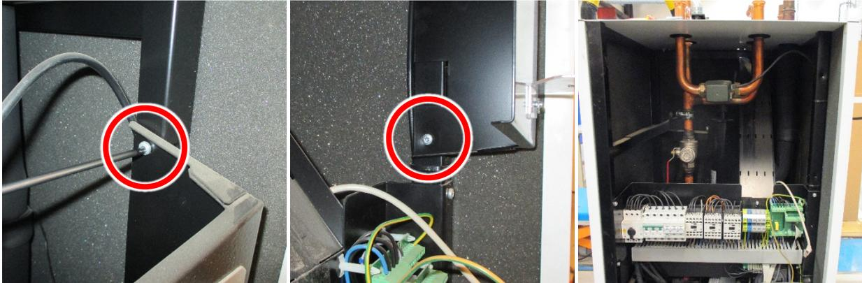
5. Kabel vom Rego 63x-Modul abklemmen: Flachbandkabel, Stromversorgungskabel mit Molex-Stecker, RJ45-Displaykabel.
