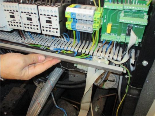
8. Anschlüsse für Pumpe P2 [6] und Pumpe P3 [7] von der Anschlussleiterplatte abklemmen. Wenn ein sekundärer gemischter Kreis installiert ist, den Anschluss des Mischventils SV1 [8] abklemmen. Anschluss für Pumpe P1 [9] abklemmen. Erdungskabel von den Pumpen ebenfalls abklemmen.
