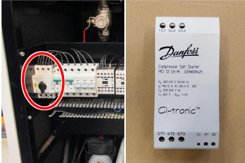
15. Kabelkanal demontieren (3 Schrauben). Anschlussmodul abschrauben (4 Schrauben) und Kabelbinder aufschneiden, sodass das Modul herausgehoben werden kann. Die Schrauben werden später wieder verwendet.
