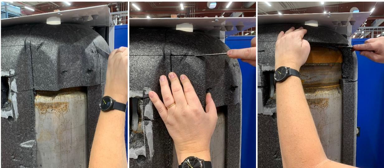
20. Das beiliegende Dämmmaterial am freiliegenden Speicher einpassen und zuschneiden. Dann die Schutzfolie abziehen und das Dämmmaterial ankleben.
