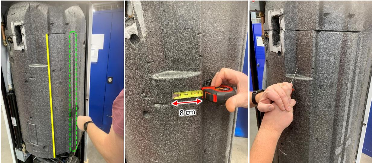
Im Bereich der grünen Strichlinie befindet sich bereits eine Verbindungsstelle zum hinteren Dämmelement. An dieser Stelle muss die Dämmung nicht aufgeschnitten werden. Das abgetrennte Dämmungsstück entfernen.
