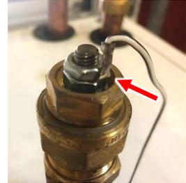
Alarmsignal (X3) von der PEL-Leiterplatte an die Fremdstromanodenkarte anschließen.
