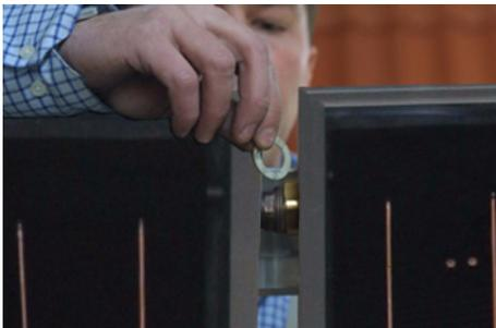
10: Kollektoren hydraulisch miteinander verbinden und diese über die Trageschienen jetzt fest verschrauben
