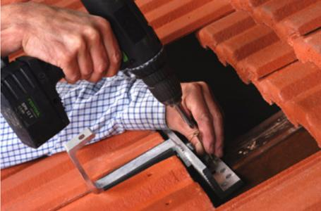
3: Dachbügelkonsole einrichten und mittels Spax auf Sparren befestigen. Dachbügelkonsole so befestigen, dass der Dachbügel sich in einem Wellental des darunterliegenden Dachziegels befindet.
