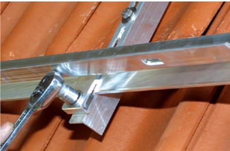
7: Trageschienen oben und unten ausrichten und mit der gerillten Fläche über die Klemmstücke fixieren
