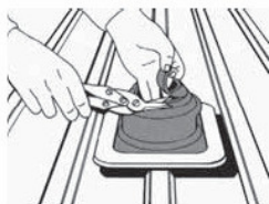
1. Dektite® an Rohr anpassen
