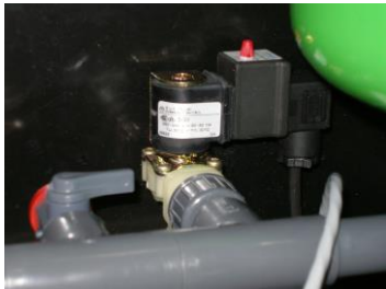
Abb. D-5: Ausspülventil montieren
