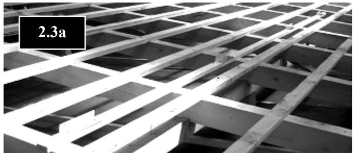
2.3a: Zwischen 2 Kollektoren wird jeweils ein Befestigungswinkel positioniert.
