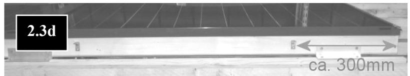
Anschließend die untere Kollektoren nach dem gleichen Prinzip mit Hilfe der Montagewinkel befestigen.
