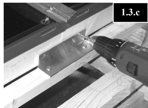
**Schritt 1.4: Obere Befestigungswinkel montieren**
