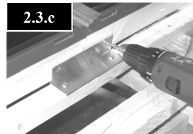
2.3.c: Kollektoren des oberen Kollektorfeldes auflegen und mit unteren Winkeln verschrauben (Spax 5x40).
