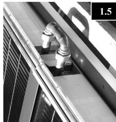
Der Kollektorvorlauf und der Kollektorrücklauf werden mit dem Wellrohrschläuchen des Kollektorschlussets AS IKE angeschlossen. Hierbei muss ebenfalls auf den korrekten Sitz der Dichtung geachtet werden. Beim Anziehen der Verschraubungen muss mit einer Zange bzw. einem weiteren Schraubenschlüssel gegengehalten (gekontert) werden, damit der Absorber nicht beschädigt wird. Die Wellrohrschläuche anschließend fixieren und ins Dachinnere leiten.
