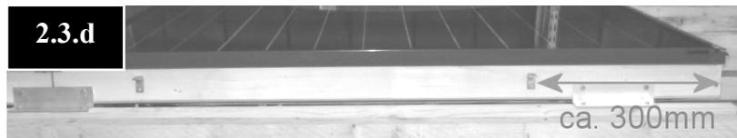
Anschließend die unteren Kollektoren nach dem gleichen Prinzip mit Hilfe der Montagewinkel befestigen.
