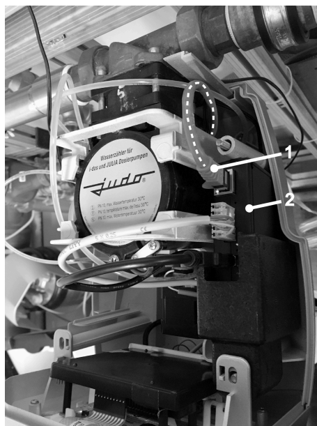
Abb. 16: LAN-Kabel anschließen
