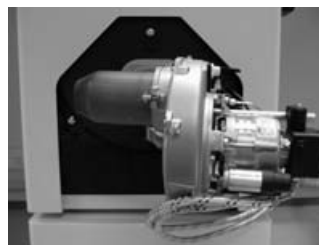
Die Schwenkvorrichtung ermöglicht z. B. eine schnelle Kontrolle der Mischeinrichtung.
