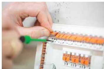
Demontaż złączki
