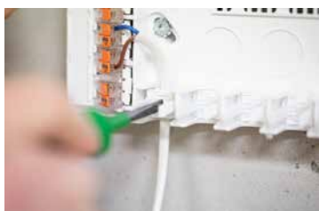
Mocowanie przewodu w elemencie odciążającym przewody
