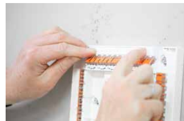
Wsunięcie paska oznaczkowego do profilu
