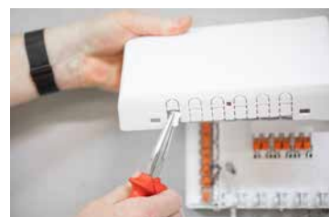
Wyłamanie zaśllepki wpustu kablowego
