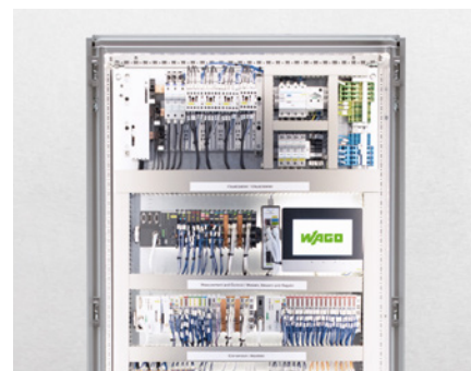
Der Klassiker: Einbau der Automatisierungskomponenten im Schaltschrank
