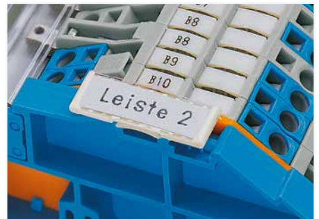
Gruppenkennzeichnung auf Sammelschienenträger mit Endklammerfunktion oder Endklammer
