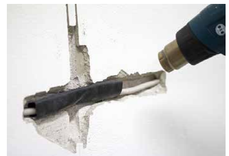
Schrumpfschlauch erhitzen und Schadstelle wieder fachgerecht verschließen.
