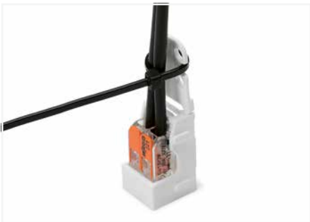
Zugentlastung mit Kabelbinder herstellen.
