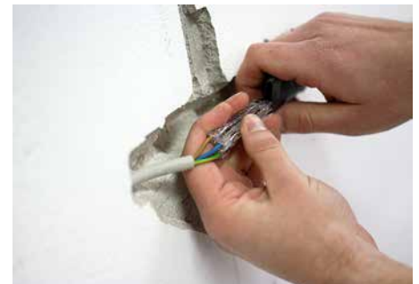
Leitung mit Leitungsreparaturset verbinden.
