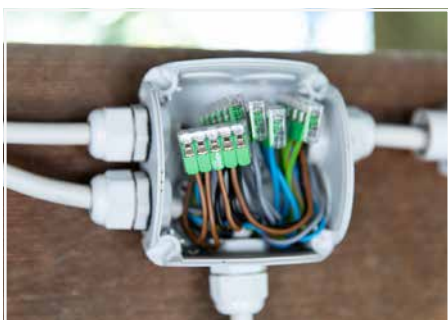
Verdrahtung in der Abzweigdose
