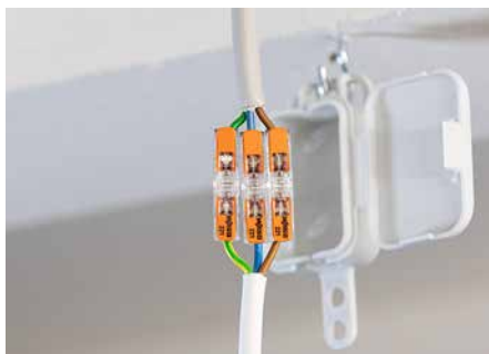
Leuchtenanschluss in Zwischendecken
