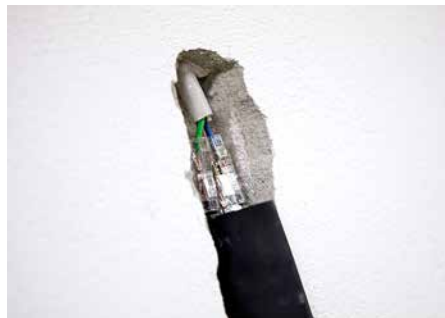
Leitung mit Leitungsreparaturset verbinden.
