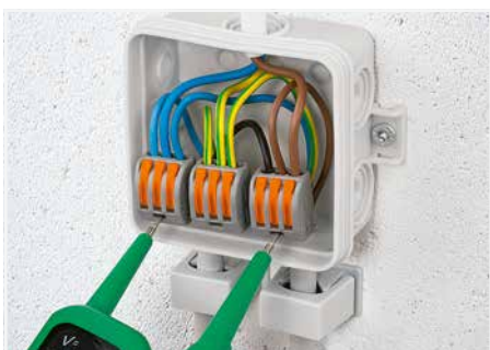
Prüfen der installierten Klemmen
