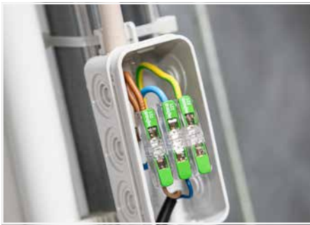
Verdrahtung in der Abzweigdose
