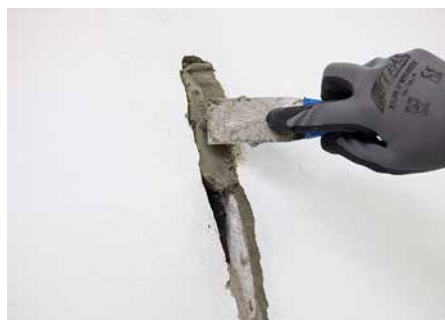
Schadstelle unsichtbar verschließen.
