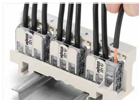
Lösen der Leiter im Befestigungsadapter
