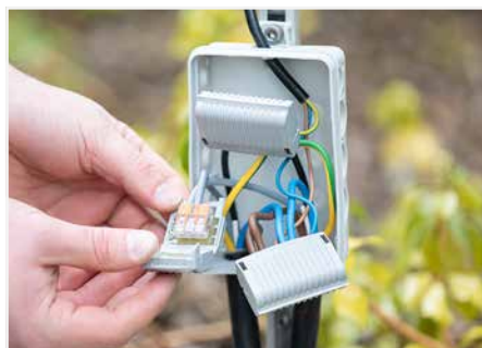
Anschluss einer Pollerleuchte
