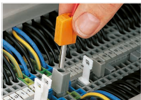
Prüfen mit Prüfstecker Hier über den Prüfadapter (209-170)
