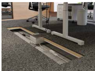
Installation von Unterflursystemen
