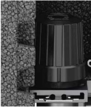
Das in der x-net Wohnungsstation pro ungemischter Heizkreis verbaute Zonenventil ist serienmäßig mit einer Kappe versehen. Achtung: ist diese Kappe zuge dreht, ist das Zonenventil geöffnet. Somit ist bei geöffneter Kappe das Ventil geschlossen!
