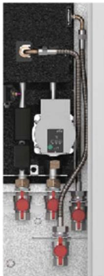
1. Beide Klammern an der Station (seitlich und vorne) lösen und die Stopfen entfernen.
