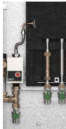
Die Pumpe muss auf den Metallwinkel montiert werden. Der Metallwinkel muss wiederum mit den x-net Kugelhahnset Wohnungsstation verschraubt werden.
